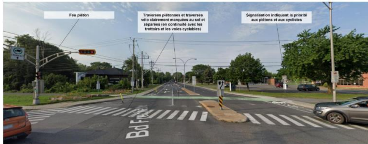
Figure 2-27 : Intersection des boulevards Fréchette et De Périgny
