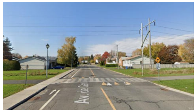
Figure 2-22 : Passage surélevé sur la rue de Gentilly (corridor scolaire) à l'intersection du sentier polyvalent
