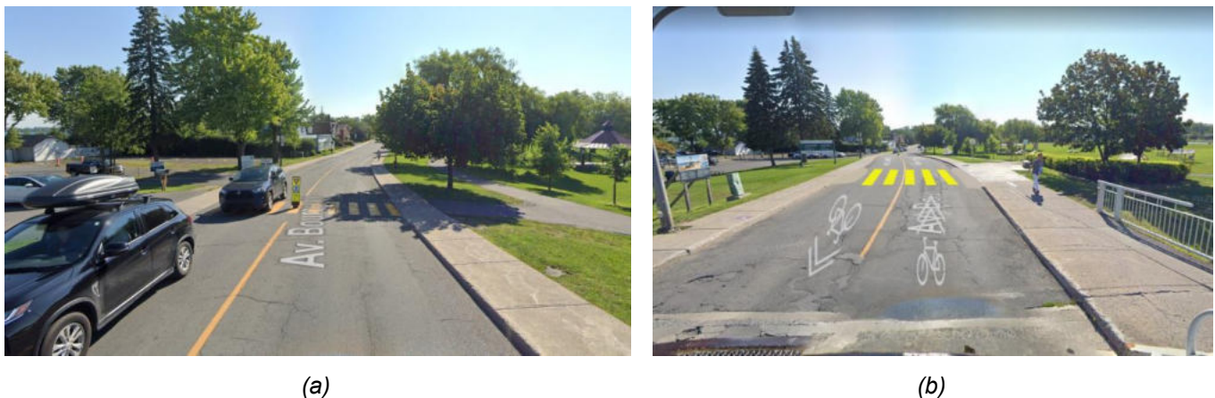
Figure 4-31 : Passage piéton sur l'avenue Bourgogne à l'est du pont des écluses actuel (a) et proposé (b)
