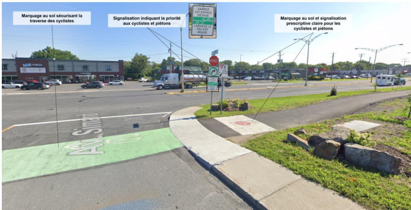
Figure 2-28 : Intersection du boulevard De Périgny et de l'avenue Simard SOURCE : GOOGLE MAPS
