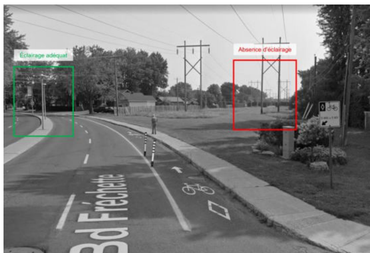
Figure 2-19 : Éclairage en bordure de la bande cyclable unidirectionnelle sur le boulevard Fréchette et du sentier polyvalent à proximité de l'avenue Kennedy SOURCE : GOOGLE MAPS
